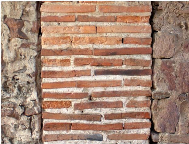
Abb. 3: Die Außenseite des dritten Pfeilers von Osten auf der Südseite
