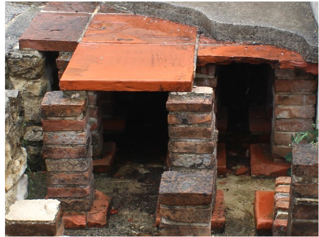
Abb. 9: Rekonstruierte Hypokaustenheizung in Carnuntum (nahe Wien)
